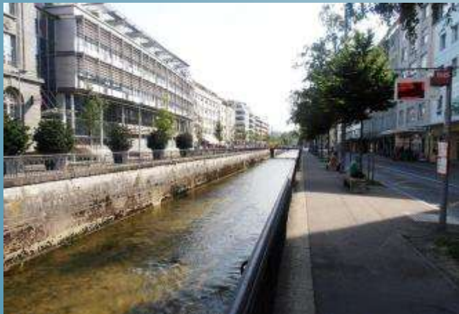
Oberer Quai: River side walk
